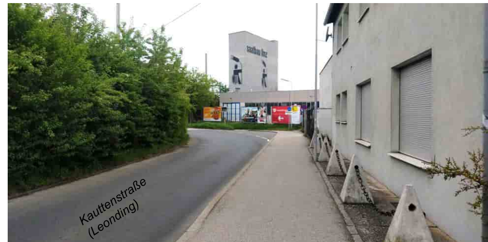
Abbildung 16: Bestehende Situation Kauttenstraße Blickrichtung Südwest
